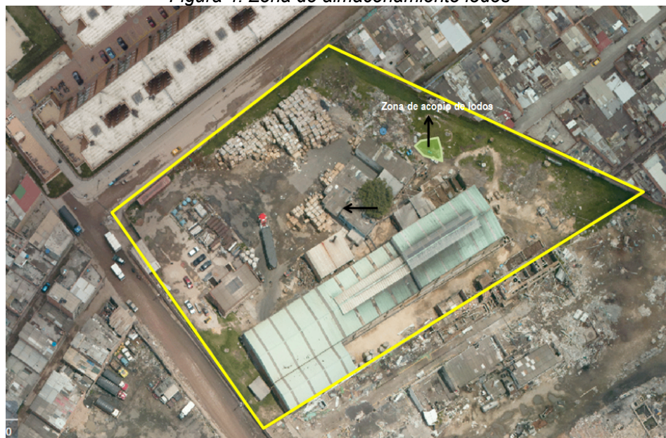
Figura 4. Zona de almacenamiento lodos
